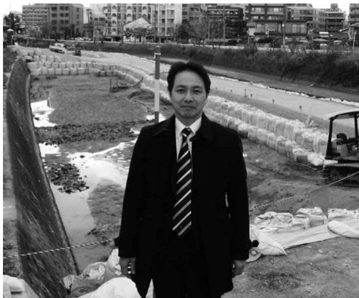
樋井川河床掘削工事現場を視察
