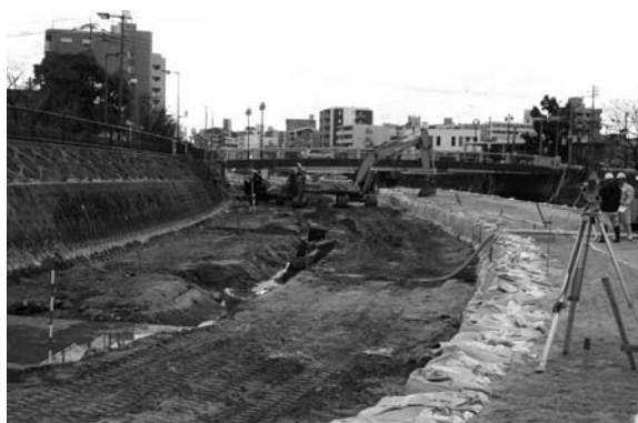
護岸補強工事(環境型張りブロック)を行っています。
