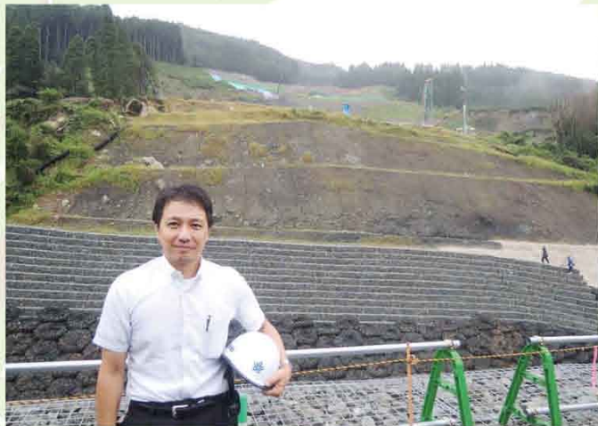
昨年7月の大雨で被害を受けた八女市の復旧現場を視察
