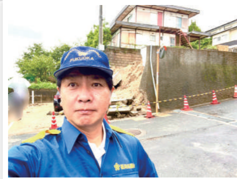
梅林で発生した擁壁倒壊の現場を視察しました。
